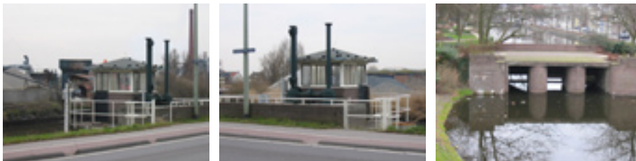
Nieuwe Veerstal (gemaal)
